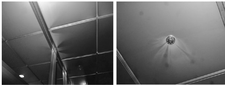
図11 天井とパネル（左）、スプリンクラー（右）の隙間から空気が流入するために発生したヤニの着色ムラ
